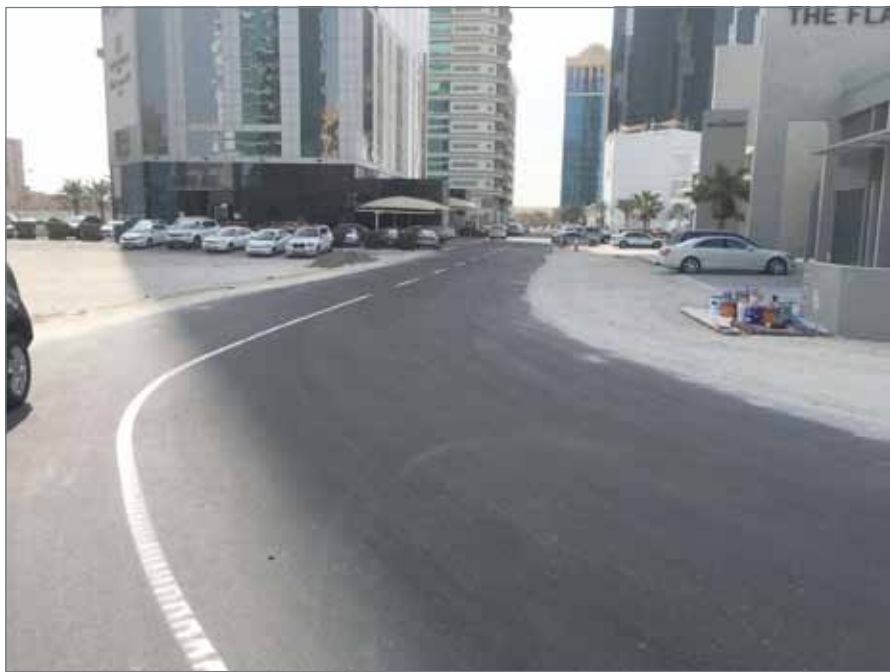
• إنشاء الطريق 2813 مجمع 428 السيف
