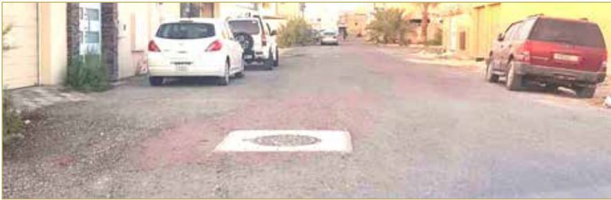
طرقات المتجمع غير معبدة رغم استكمال أعمال الصرف الصحي
