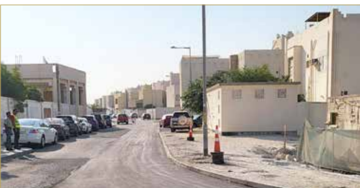
الانتهاء من انشاء غرف التفتيش ورصف الطرق - سترة 609
