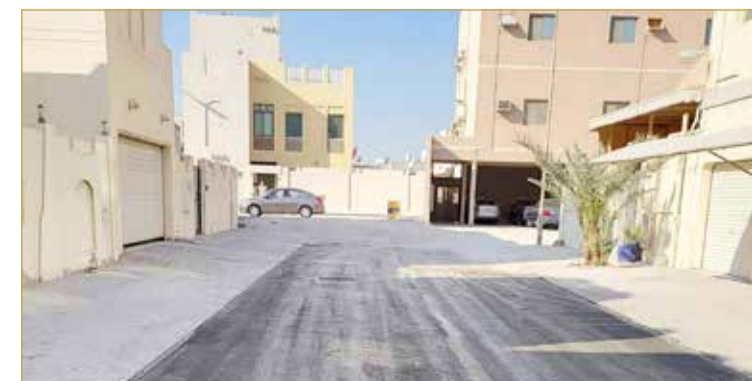
الانتهاء من رصف الطرق
