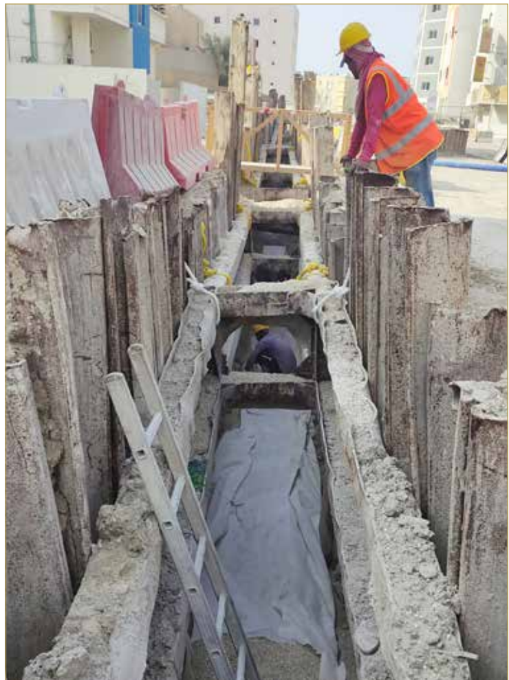
جانب من أعمال المشروع
